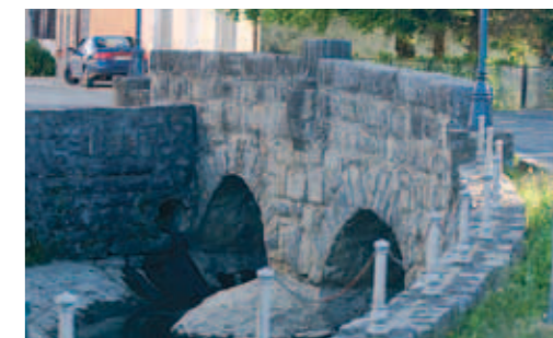
Il ponte di pietra attraverso Gate - Jaruge costruito nel 1801.
